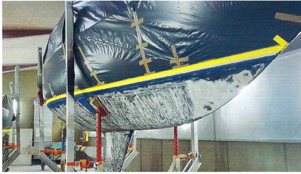
Vor dem Beginn der Sanierungsarbeiten wird die Yacht bis auf das Unterwasserschiff in stabiler Folie verpackt, sie schützt vor Strahlgut und Sprühnebel beim Spritzen.
