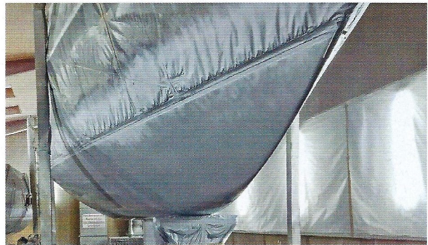
Ein zusätzlich aufgespritzter Vinylestersealer bildet den sicheren Haftgrund für die folgenden Antifoulinglagen.
