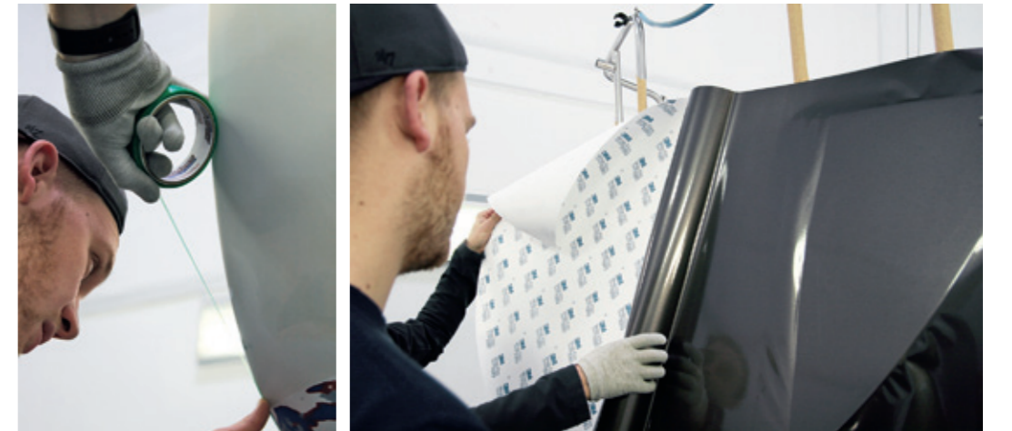
Die Kanten werden mit einem speziellen Tape abgeklebt (links). Die Folie wird grob zugeschnitten aufgebracht. Das Schutzpapier wird von der Folie entfernt, nicht die Folie vom Schutzpapier (rechts)
