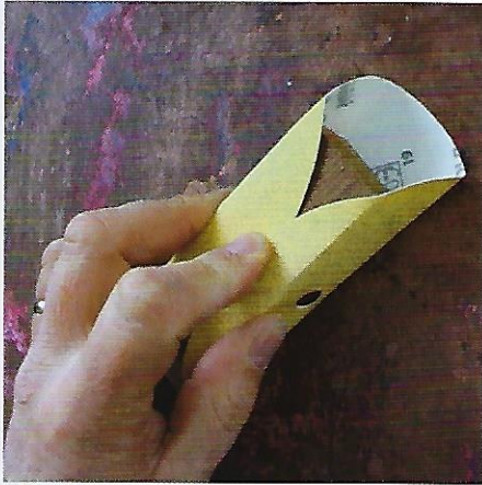
Der Schleiftest hilft bei der Osmose-Erkennung.
